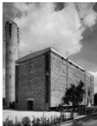
Pfarrkirche St. Wendel Frankfurt 1956-57
